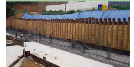
· 공사명 : 남양리 웰니스 요양원 신축공사 · 발주처 : 민간조합 · 원청사 : 티케이씨엔씨
