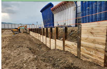
② 1차 굴착 및 토류판 설치
