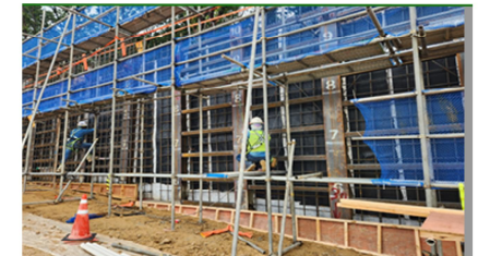
⑧ 합벽용 'ㄱ'형강 설치 및 철근 배근
