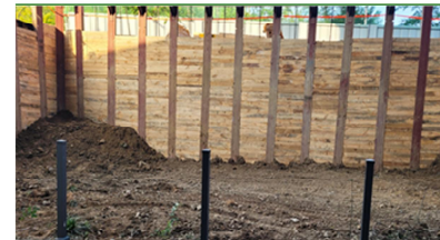
· 공사명 : 한국수력원자력 본사사옥 UPS 배터리실 공사 · 발주처 : 한국수력원자력 · 원청사 : HS건설
