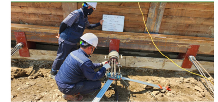
③ 중앙부 다각도 앵커 설치 및 인장
