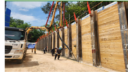
⑤ 기초콘크리트 타설
