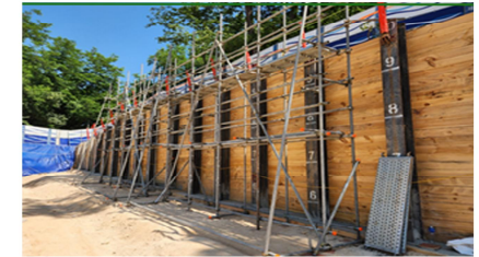
⑥ 비계파이프 설치
