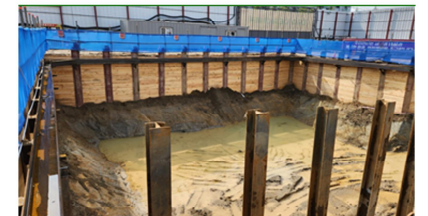
· 공사명 : 의왕시 오전나구역 주택재개발 정비사업 · 발주처 : 민간조합 · 원청사 : 태영건설
