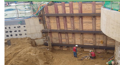
· 공사명 : 평택 P3 터널공사 · 발주처 : 삼성전자 · 원청사 : 특수건설
