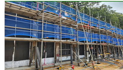
⑦ 드레인보드 설치
