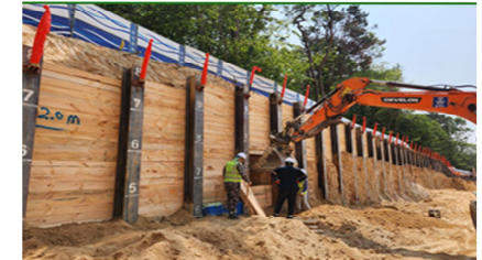
④ 굴착 및 토류판 설치
