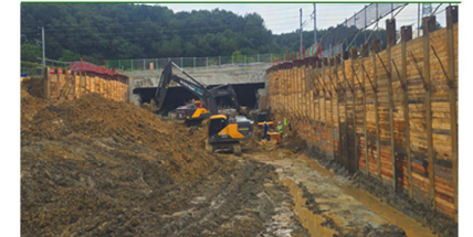
· 공사명 : 이천역세권 기반시설공사 · 발주처 : 이천시 · 원청사 : 운호엔지니어링
