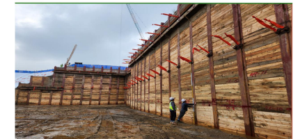
⑤ 시공 완료
