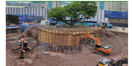
· 공사명 : 화성파크드림 구수신공원 신축공사 · 발주처 : 구수산민간공원 · 원청사 : 화성개발
