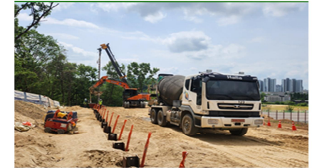
② 흙 콘크리트 채움
