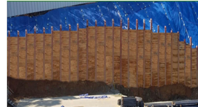
· 공사명 : 화성비봉 배수지 진입도로공사 · 발주처 : LH한국토지주택공사 · 원청사 : 아진씨엔씨
