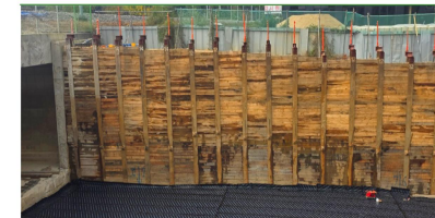
⑤ 시공 완료
