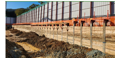
④ 굴착 및 토류판 설치
