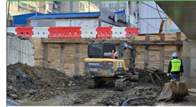
· 공사명 : 굴포천 생태조성사업 · 발주처 : 한국환경공단 · 원청사 : 삼부토건
