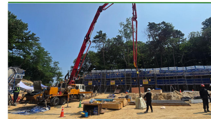
⑨ 합판 설치 및 콘크리트 타설
