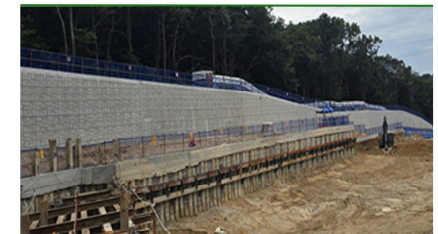
⑩ 면정리 후 공사완료
