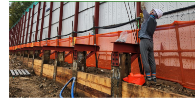
③ 상부 직립 브라켓 설치 및 인장
