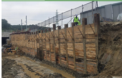
④ 시공 완료
